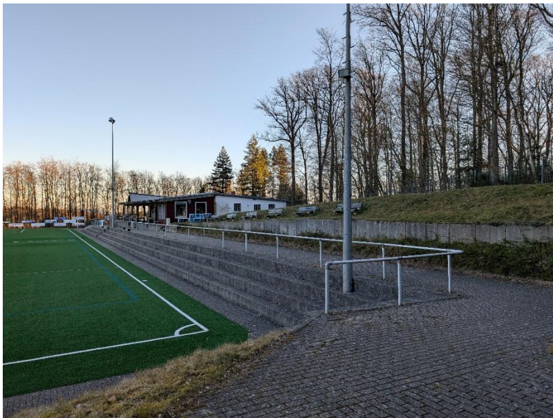
Abbildung 3 abzubrechendes Vereinsgebäude im Hintergrund und Fußballfeld
