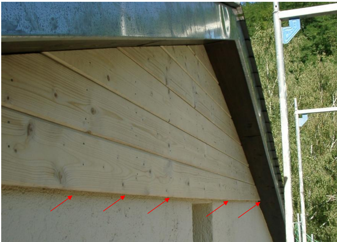
Abbildung 10 Hier mit Nut-Federbrettern verschalt, die Einflugbereiche befinden sich in bestimmten Abständen (etwa 50cm) unter dem Abschlussbrett (Pfeil) in einer Ausprägung von jeweils 15cm. Somit sind bei einer üblichen Grundlinienlänge von häufig 4m etwa 8 Öffnungen im Bereich der waagerechten Latte am Abschlussbrett vorzusehen.
